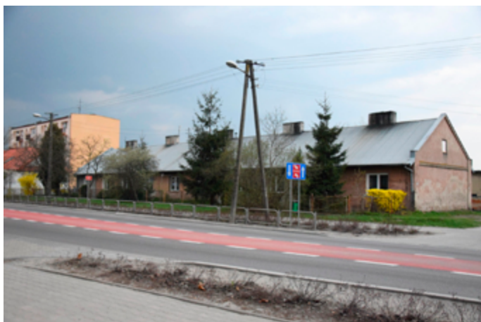
Czworaki – budynki należące do dworu. Pani Marta często je odwiedzała i pomagała mieszkańcom.
